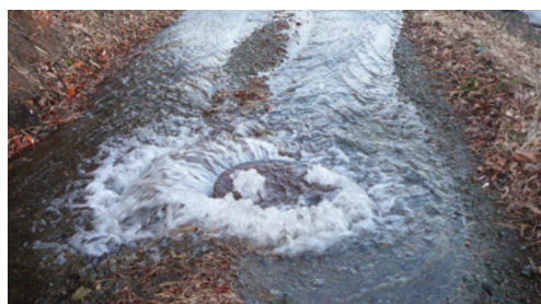
空気弁からの漏水
