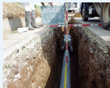
塩化ビニル管布設
