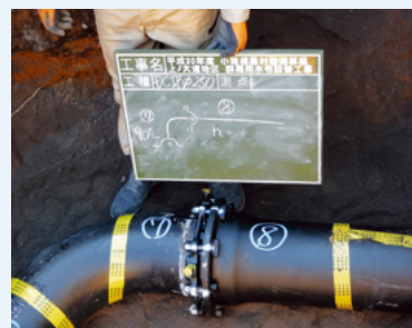
ダクタイル鋳鉄管布設
