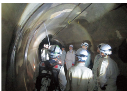
施設見学会トンネル内
