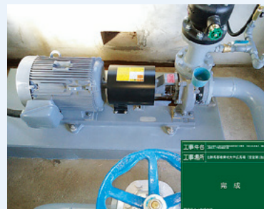
ポンプ・モーター更新
