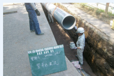
塩化ビニル管布設
