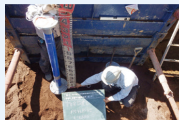
空気弁設置
