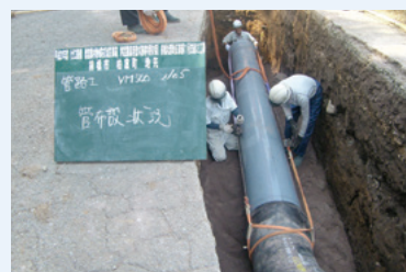
塩化ビニル管布設
