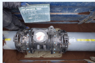
制水弁設置
