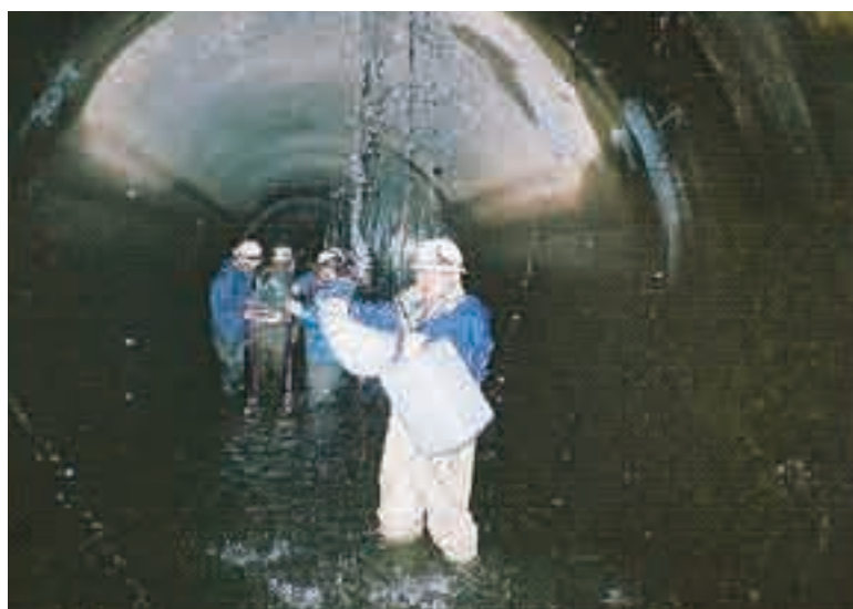
有馬トンネル内部調査の様子
