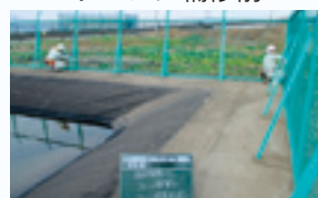
フェンス補修施工中
