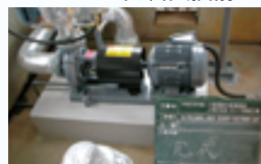
ポンプ・配管交換完了
