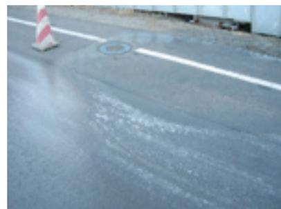
空気弁からの漏水による路面凍結状況
