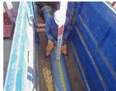
石綿管から塩ビ管へ改修
