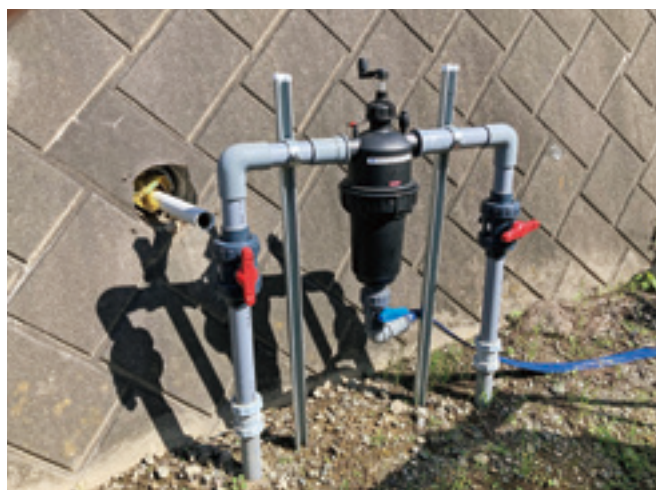
除塵機（フィルター）の設置状況
