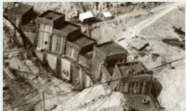
山根ダム建設の状況
