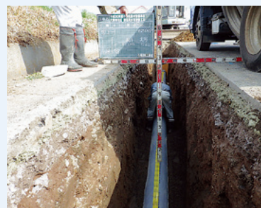
塩化ビニル管布設
