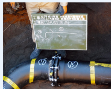
ダクタイル鋳鉄管布設
