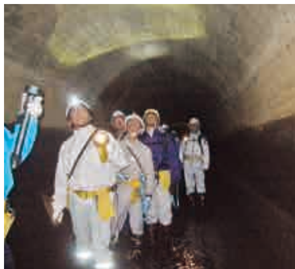
関係者による施設状態の確認状況
