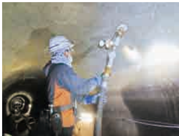
トンネル背面空洞箇所の充填
