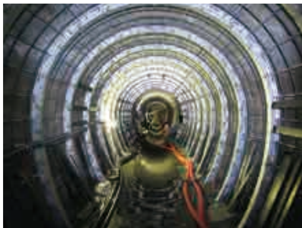
トンネル補強（鋼製支保工設置）
