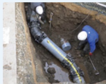
塩化ビニル管布設
