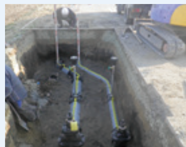
塩化ビニル管布設
