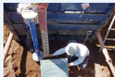
空気弁設置
