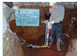
空気弁設置
