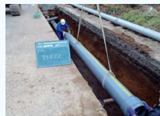
塩化ビニル管布設
