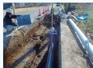
塩化ビニル管布設
