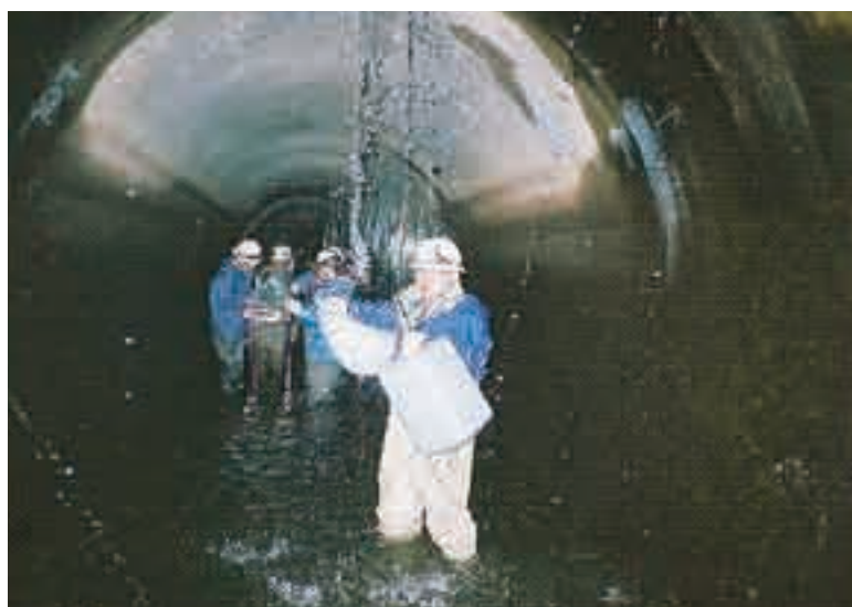
有馬トンネル内部調査の様子
