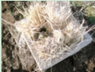
【凍結防止対策】ワラ・もみガラ・毛布・ビニール等を詰めて保護して下さい
