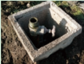
【凍結防止対策】ワラ・もみガラ・毛布・ビニール等を詰めて保護して下さい
