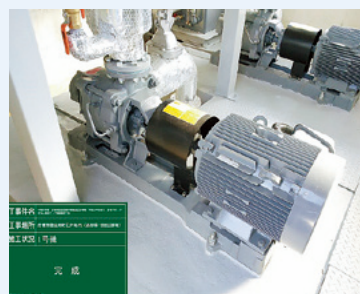
西部第13加圧機場 ポンプ・モーター更新
