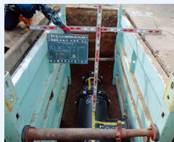
白岩地区 ダクトイル鋳鉄管布設
