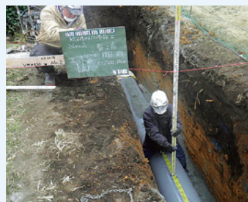
板橋地区 塩化ビニル管布設
